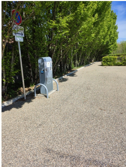
Aménagement des places parking salle des fêtes
