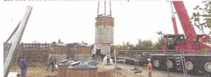
La mise en place délicate des 6 containers./Photo DDM
