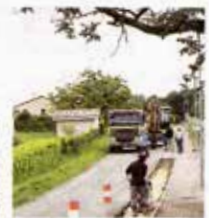
La voie piétonne en travaux. / Photo DOM
